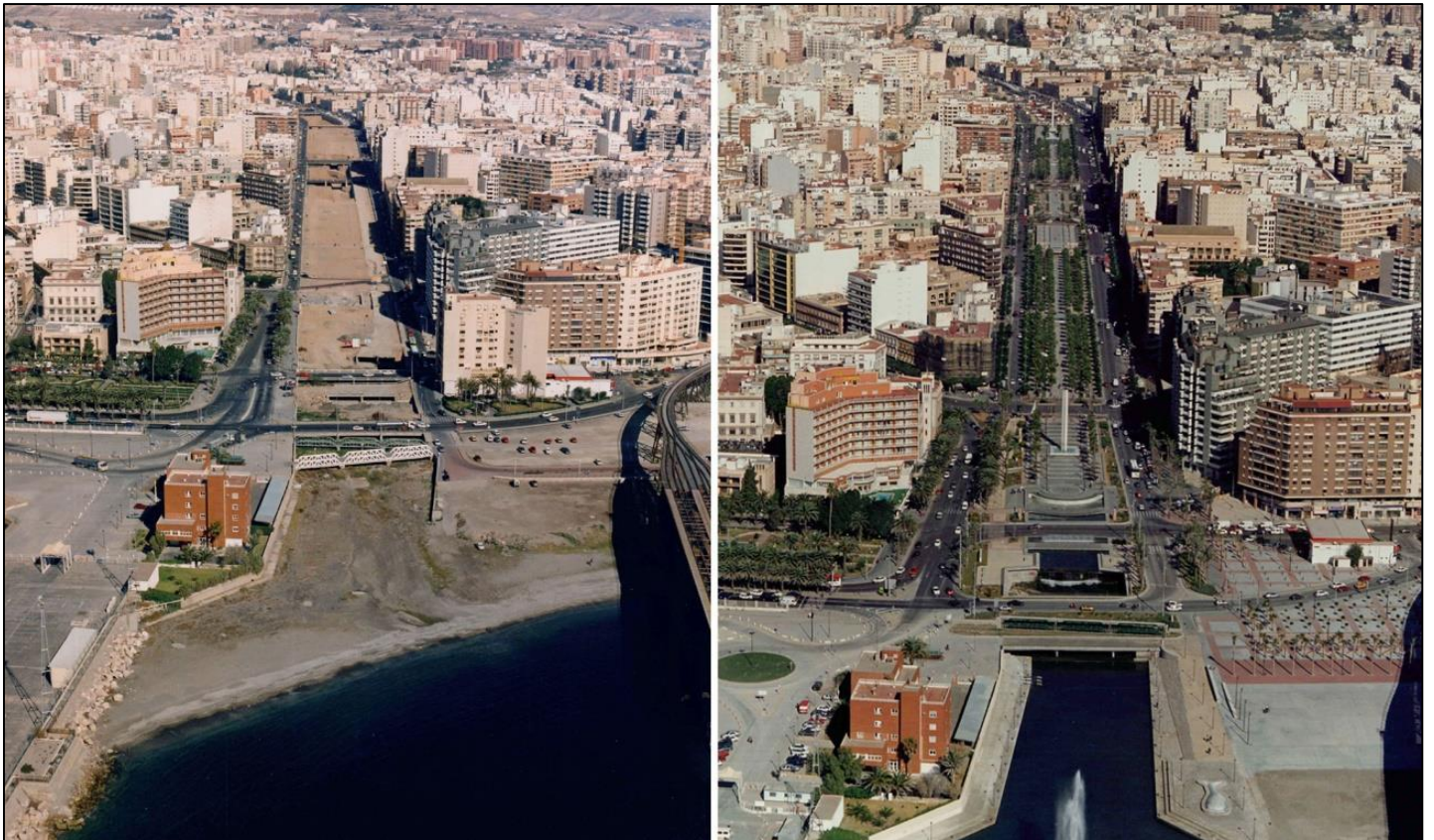
Rambla encauzada y soterrada en la ciudad de Almería
